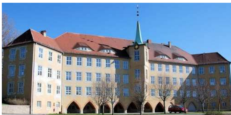
Rys 1. Widok elewacji frontowej budynku [5].
