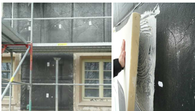
Rys 3. Zabudowanie izolacji próżniowej VIP na ścianie zewnętrznej – widok ogólny.
